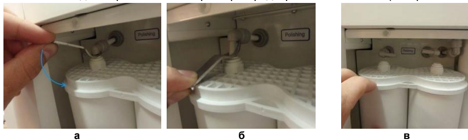
Рисунок 33. Замена модулей тонкой очистки и деионизации.
